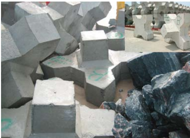
5 | Xbase™ blokken bij laag water Bar Beach, Nigeria (inzet: Xbase™ blokken in opslag)
